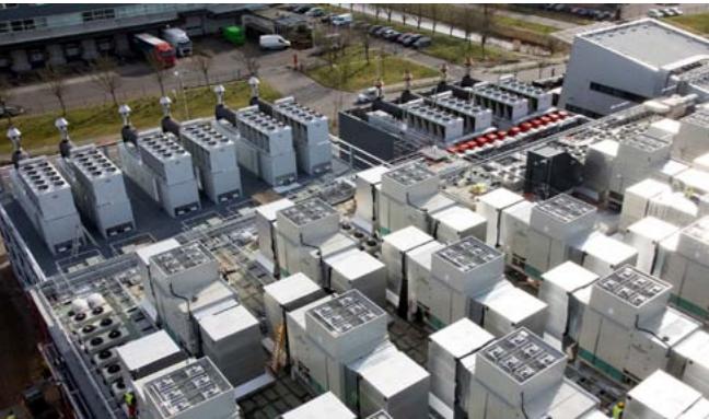
Dezentral Energieanlage von Rolls-Royce Power Systems AG, hier: Vor-Ort-Strom-Datenzentrum Amsterdam Rolls-Royce Power Systems AG decentralised energy system, here: onsite energy data centre Amsterdam
